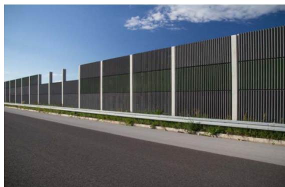
Slika 9. Betonske barijere za zaštitu od buke s recikliranom gumom – RUCONBAR Figure 9. Rubberized concrete noise barrier RUCONBAR
