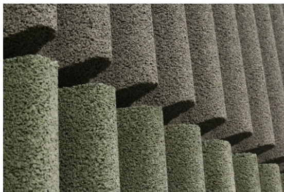
Slika 9. Betonske barijere za zaštitu od buke s recikliranom gumom – RUCONBAR Figure 9. Rubberized concrete noise barrier RUCONBAR
